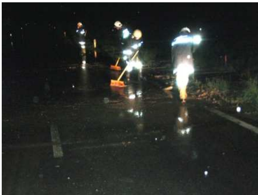
Beseitigung von Unwetterschäden in Ort i. I.
